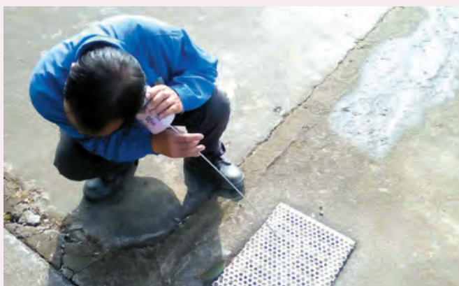
使用檢漏儀查找看不見的滲漏位置
